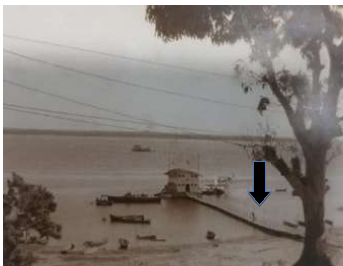
Figura 1- Época do Terminal aquaviário
