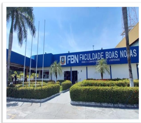
Imagem 13: Prédio da Faculdade Boas Novas
