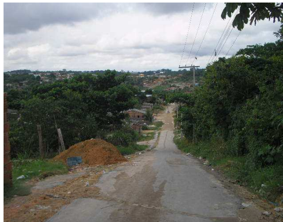
Imagem 23 – Loteamento Rio Piorini: infraestrutura do arruamento nas ruas adjacentes a principal. Foto: Tatiana Barbosa, janeiro de 2009.
