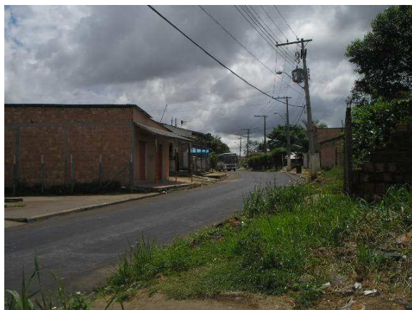
Imagem 22 – Loteamento Rio Piorini: infraestrutura do arruamento na rua principal. Foto: Tatiana Barbosa, janeiro de 2009.
