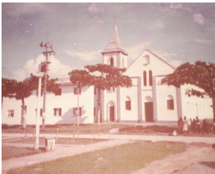
Antiga Igreja Matriz Nossa Senhora de Guadalupe destruída por causa das rachaduras ocasionadas pela queda dos barrancos – 1981 (Fonte: IBGE)
