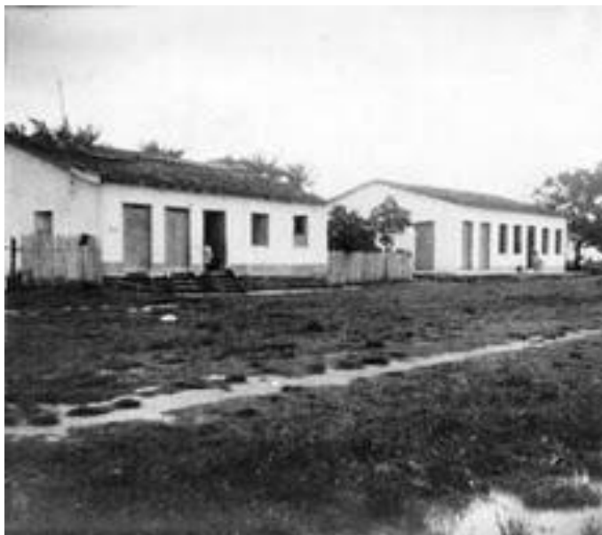
Rua Presidente Vargas que foi destruída pela erosão do barranco – 1956 (Fonte: IBGE)
