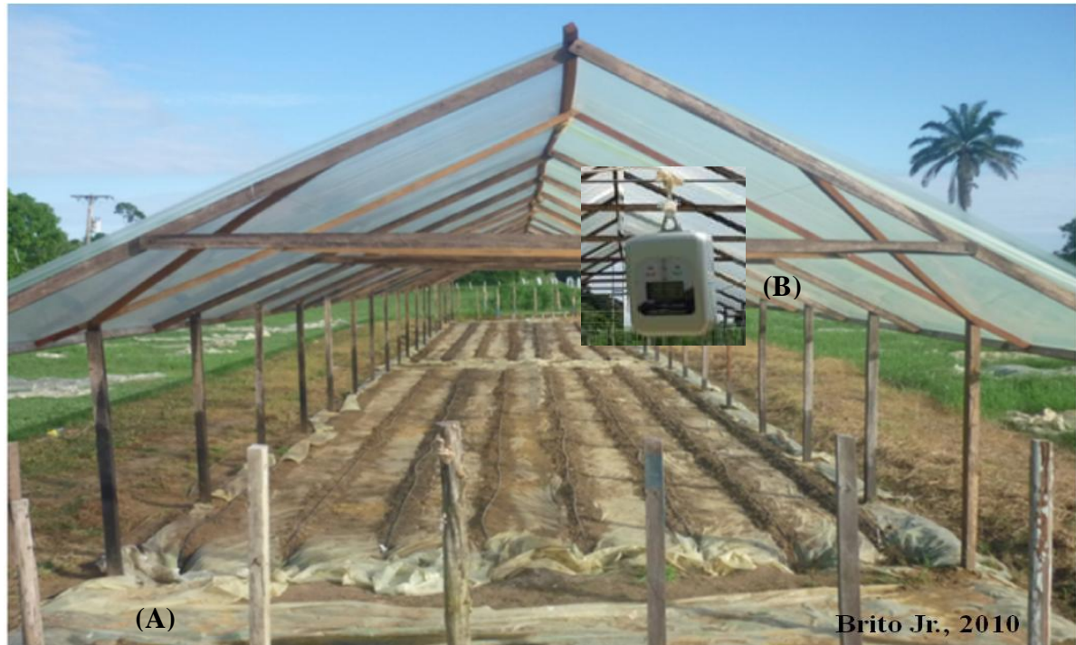
Figura 2. Casa de vegetação modelo capela adotada no experimento de cultivo protegido de tomateiro em substrato (A) e termohigrógrafo (B). Iranduba, AM, 2010.
