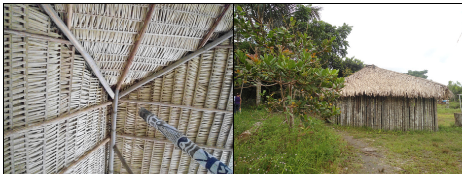
Figura 7: Parte interna do teto da Oca da Aldeia Terra Preta (Maraguá) o topo do mastro com os grafismos Maraguá. Ao lado a oca vista dos fundos.
