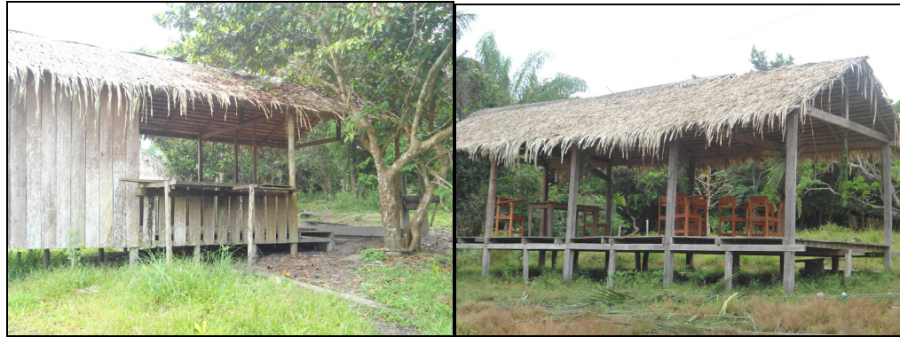
Figura 25: Escola aberta na aldeia Terra Preta, rio Abacaxis.
