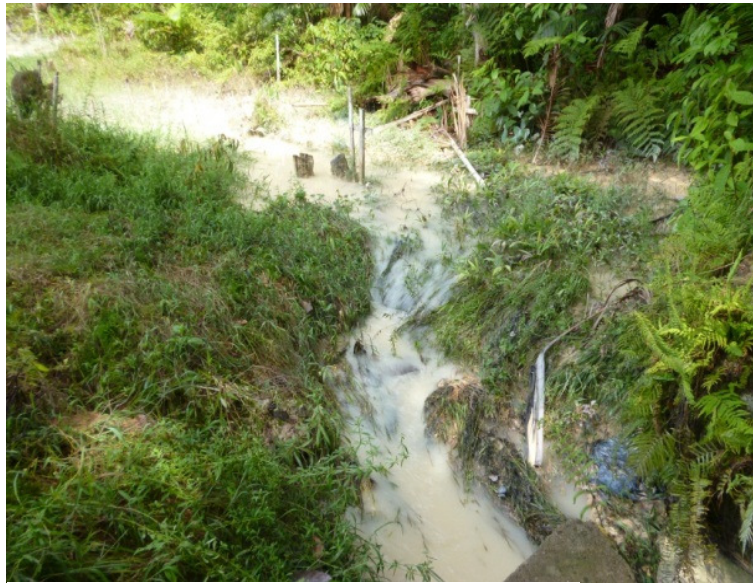
Figura 18: Erosão presente no ponto 01.
