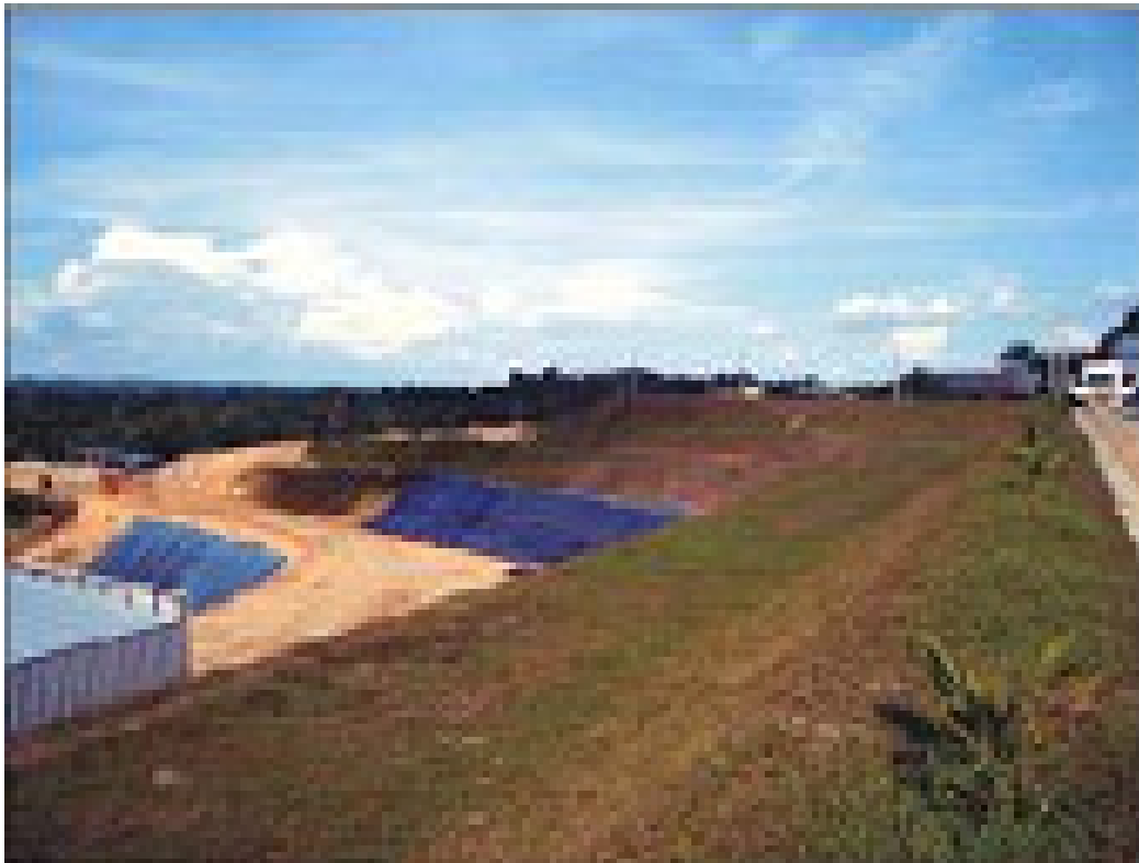
Figura 5: Instalações da CETRAM.
