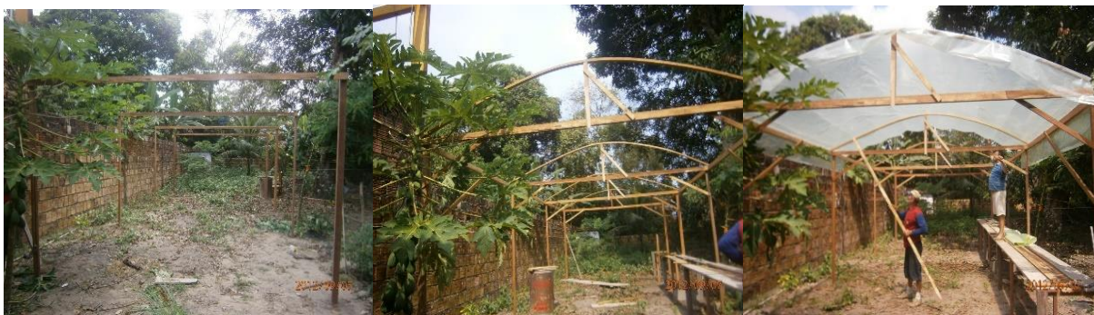
Figura 2 - Construção de casas de vegetação tipo arco
