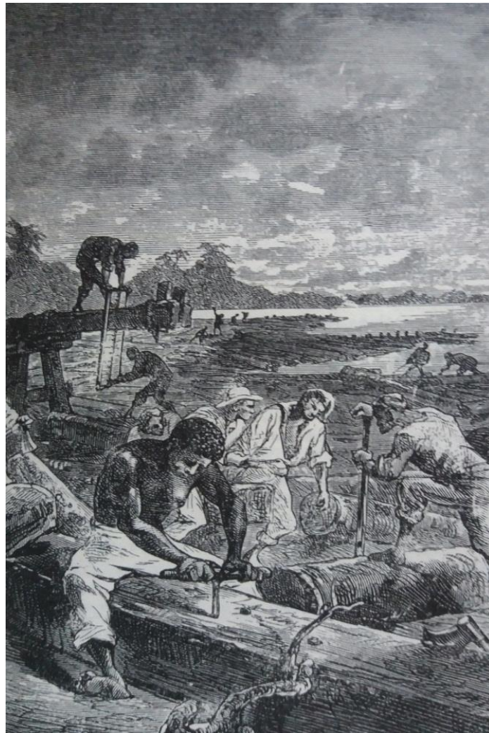
Figura 11. "A construção começou sem demora". Il. de Bennet In: VERNE, Júlio. A Jangada , p. 91.
