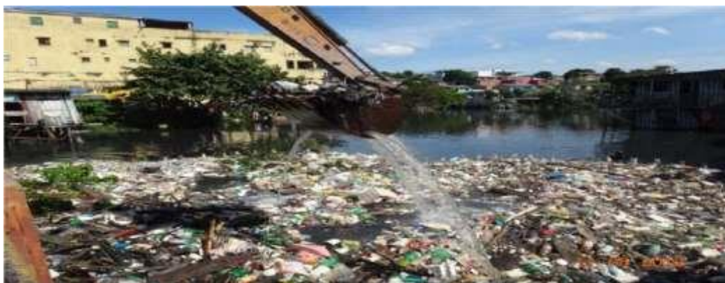
Figura 42 - Limpeza do igarapé da Cachoeira Grande no São Jorge
