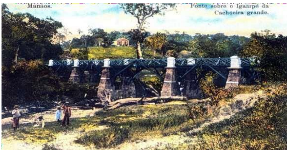
Figura 22 - Imagem da Ponte sobre o Igarapé da Cachoeira Grande (São Jorge)
