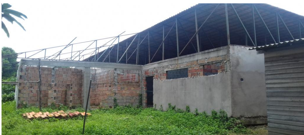
Figura 7. Obra parada da UBS. Fonte Georgio Ítalo, 2016.
