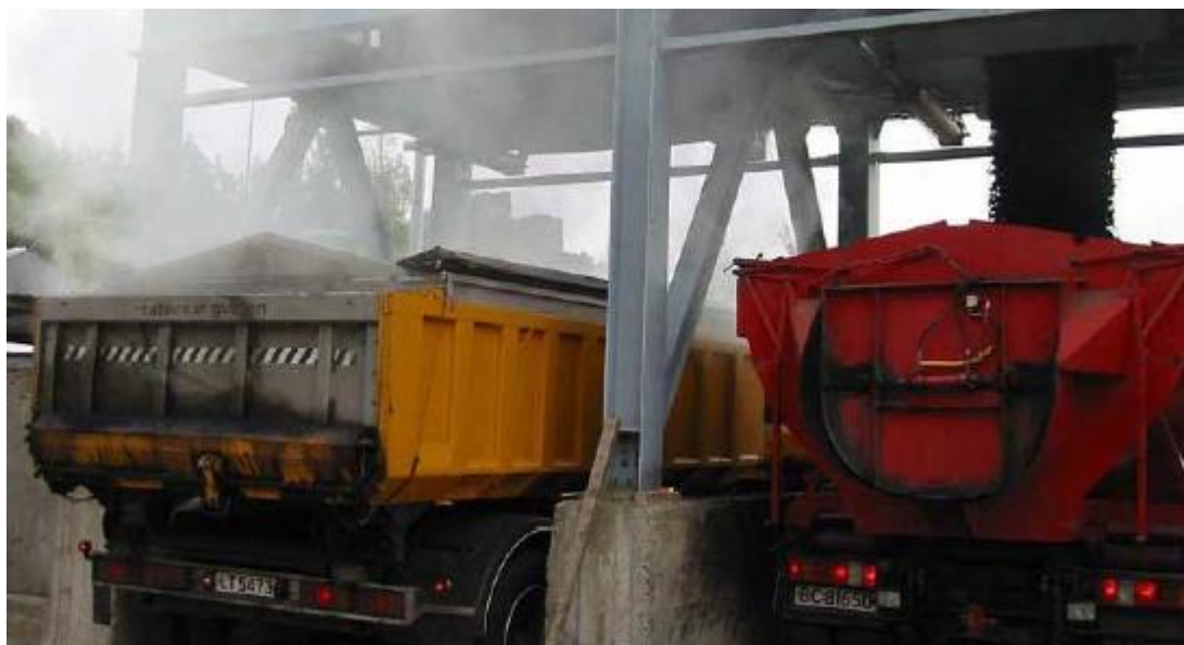
Figura 6 – Diferença entre o vapor emitido, mistura a quente, a 155°C (esquerda) e mistura morna, a 110°C (direita).
