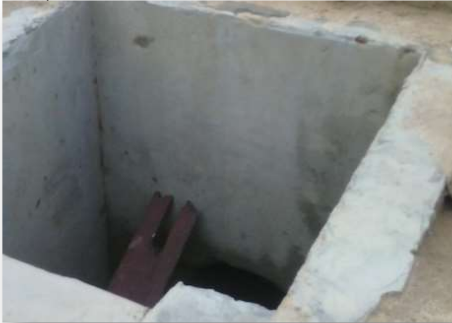
Figura 08: Esconderijo das crianças nas galerias do sistema de esgoto em construção na orla.
