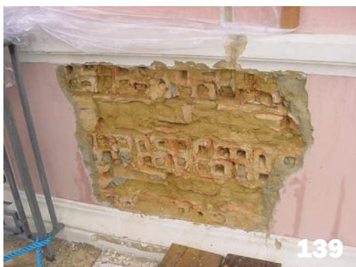
Fig. 139 e 140 – Retirada de amostras de argamassa das fachadas do Teatro Amazonas para análise estratigráfica de traço. Fonte: Acervo da Casa do Restauro.
