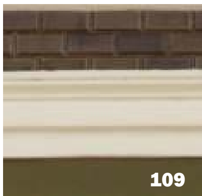
Fig. 109 – Detalhe de fachada: a faixa inferior, em massa acrílica, recebe pintura em tonalidade próxima ao revestimento cerâmico original, na faixa superior. Foto: Márcia Honda N. Castro.
