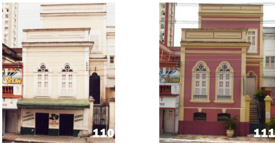
Fig. 110 e 111 – Imóvel do entorno do Teatro Amazonas, antes e após a intervenção: a retirada do toldo sobre o porão revela os guarda-corpos originais das janelas do 1º. pavimento. Fotos: Acervo da Casa do Restauro e Márcia Honda N. Castro.
