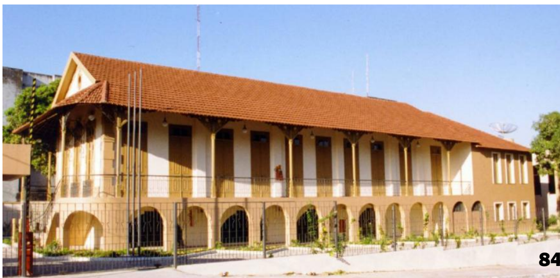
Bens Tombados a Nível Estadual. Fig. 80 – Palácio Rio Negro; Fig. 81 – Penitenciária Desembargador Raimundo Vidal Pessoa; Fig. 82 – Ponte Benjamin Constant; Fig. 83 – Relógio Municipal; Fig. 84 – Tribunal de Contas da União. Fotos: Antônio Carlos Nascimento, exceto Fig. 81, de Sammya Cury.
