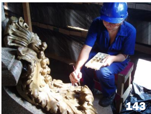
Restauro do Monumento à Abertura dos Portos: Fig. 141 – Higienização. Fig. 142 e 143 – Reintegração cromática. Fig. 144 – Restauradora Elisabete Chaves recebe universitários de Arquitetura e Urbanismo em visitação à obra. Fotos: Márcia Honda N. Castro.
