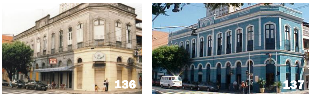
Fig. 136 e 137 – Imóvel do entorno do Teatro Amazonas antes e após a intervenção, recebendo cromatização unificada. Fonte: Acervo da Casa do Restauro.
