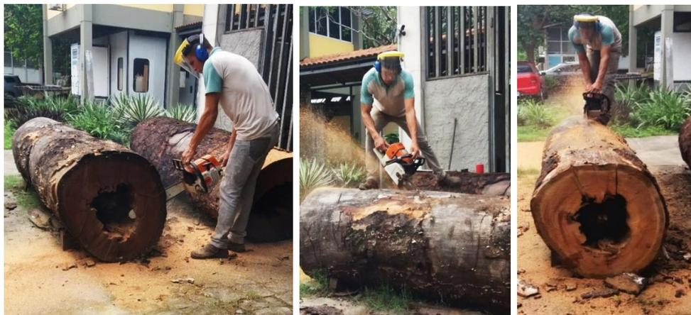
**Figura 8.** Retirada do disco de madeira utilizado na caracterização da madeira e desdobramento das toras de madeira utilizando a motosserra. **Fonte:** Próprio Autor.
