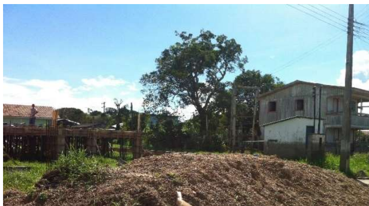
Figura 6. Edificação institucional em construção localizada em área inundável, Amazonas
