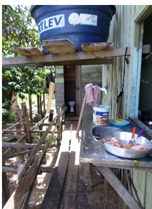
Figura 12. Infraestrutura de uma escola tipo palafita em Iranduba/AM (banheiro, caixa d'água, área de serviço)
