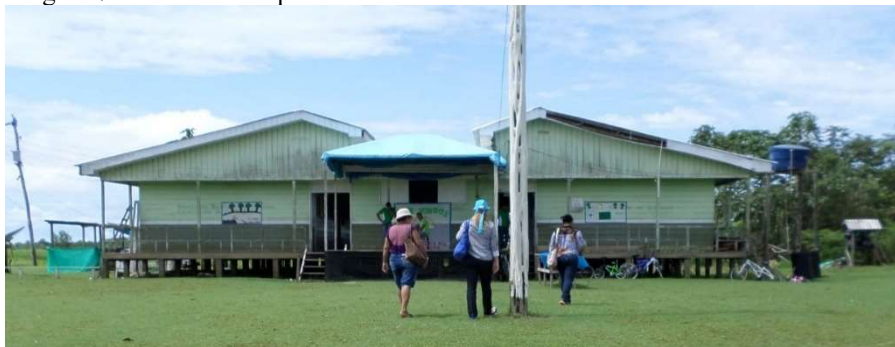
Figura 7. Escola Municipal Santa Luzia construída de madeira na várzea em Iranduba/AM
