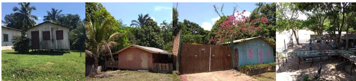
Figura 24. Edificações vernaculares residenciais e comerciais da Vila de Paricatuba
