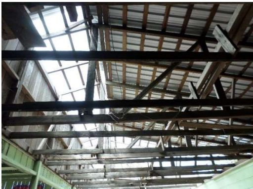
Figura 16. Estrutura do telhado de madeira na escola de Iranduba/AM
