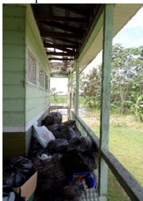
Figura 8. Resíduos sólidos da escola armazenados de forma inadequada
