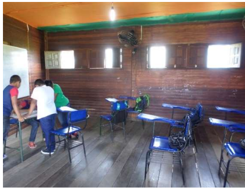
Figura 17. Paredes, esquadrias e assoalho de madeira na escola de Iranduba/AM
