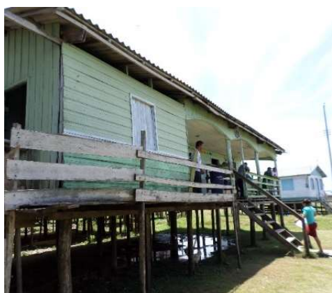
Figura 11. Fachada principal da escola em Iranduba/AM
