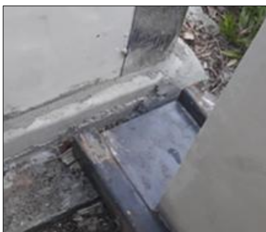
Figura 59 – Encaixes das guias pré-fabricadas e cantoneiras metálicas do módulo volumétrico de ensaio.
