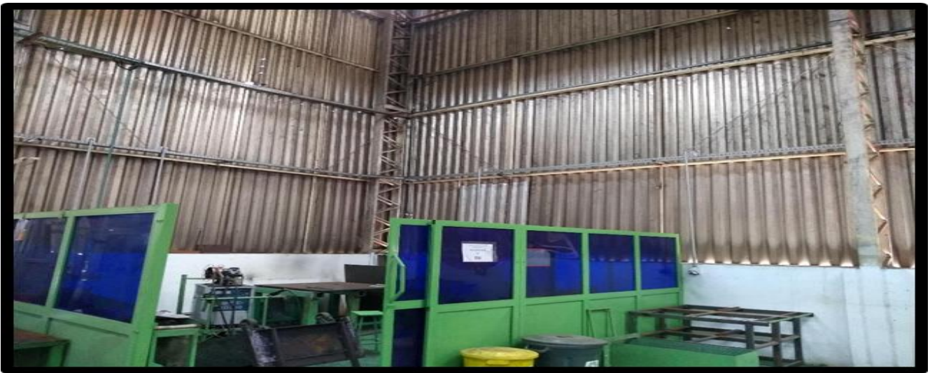
Figura 20 - Área de soldagem antes das melhorias Fonte: Autores, 2019
