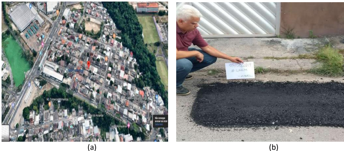
Figura 27 – Pavimentação do trecho experimental; (a) localização do trecho e (b) aplicação de camada asfáltica com geogrelha de juta.
