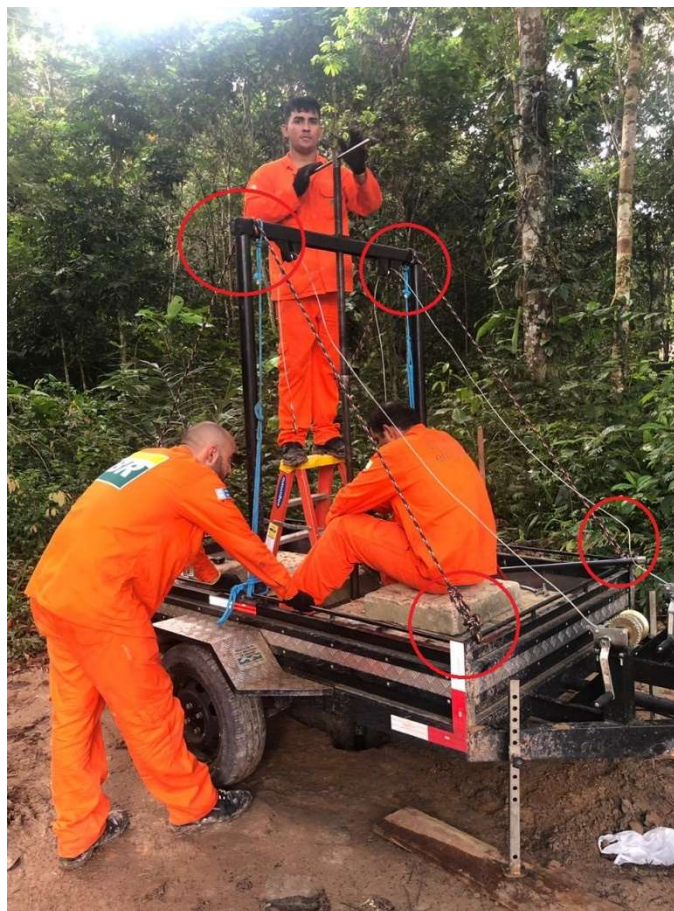
Figura 77 - Funcionamento das cordas improvisadas durancravamento da ponteira.
