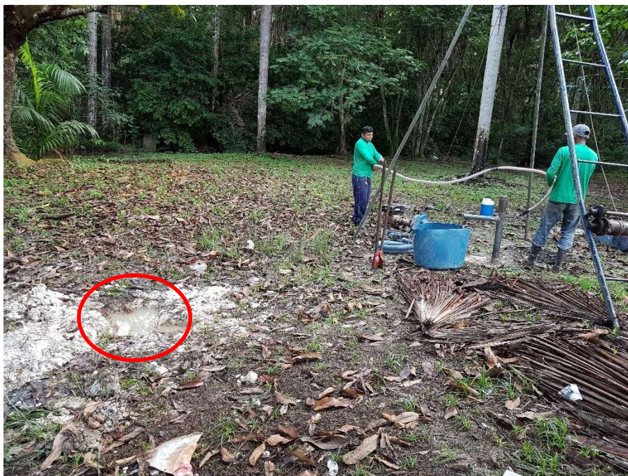
Figura 45 - Execução do Ensaio de Sondagem no Segundo Ponto, destacado em vermelho a posição do ensaio de palheta.
