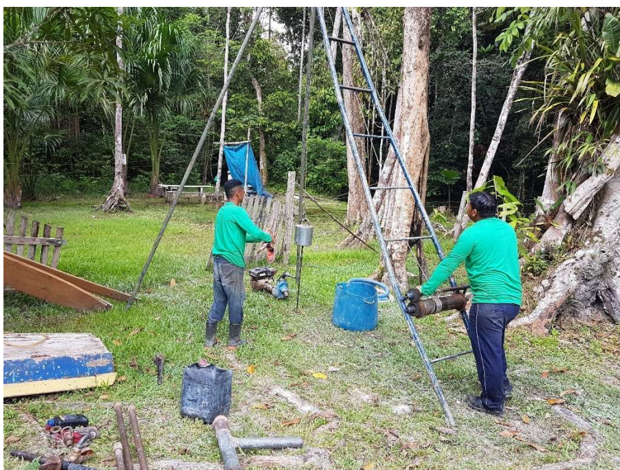
Figura 46 - Execução do Ensaio de Sondagem no Terceiro Ponto.
