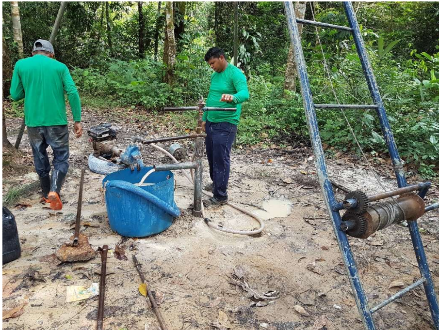
Figura 44 - Execução do Ensaio de Sondagem no Primeiro Ponto.
