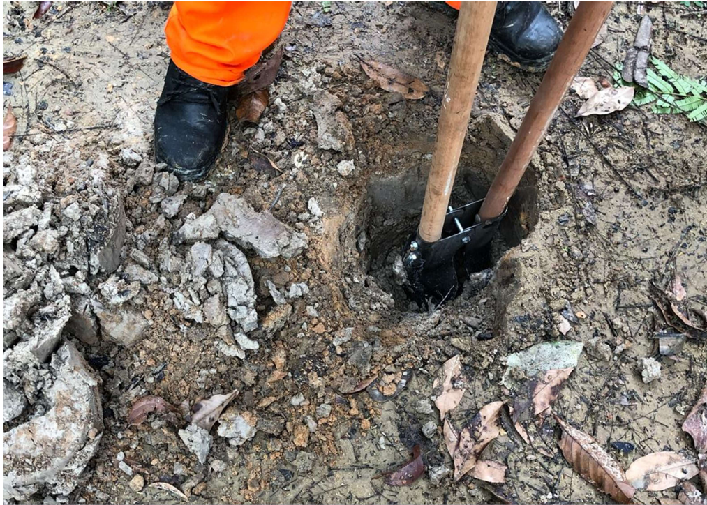
Figura 66 - Escavação prévia de solo para a exclusão de material orgânico.
