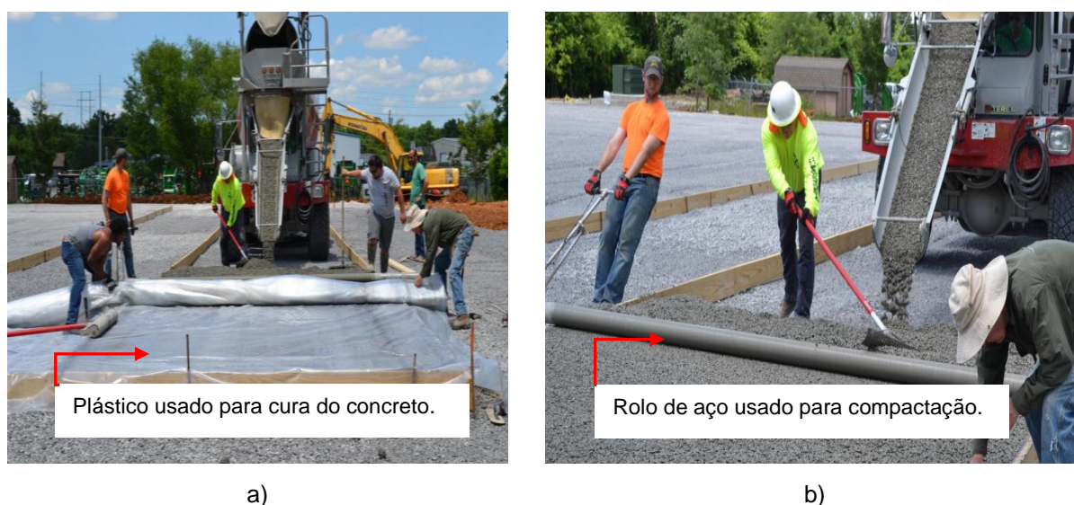
Figura 11: Método de cura para concreto permeável.
