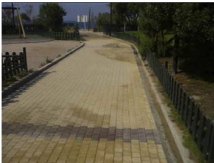
Figura 3: Pavimento frio aplicado no Parque Flisvos. Fonte: Santamouris et al. , 2012.
