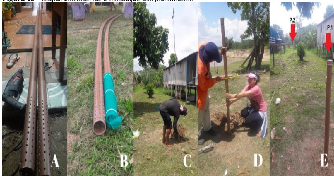
Figura 15 - Etapas construtivas e instalação dos piezômetros
