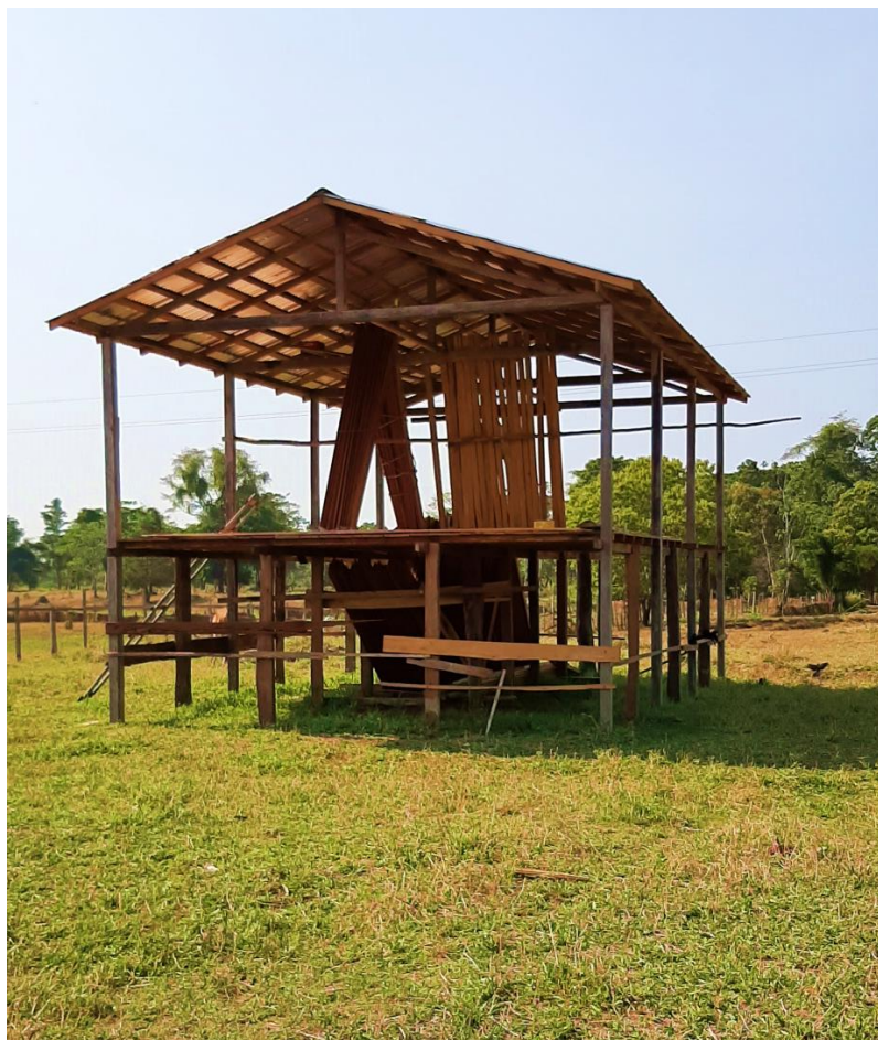
Figura 19: Casa em fase de construção. Fonte: SENA, (2020)
