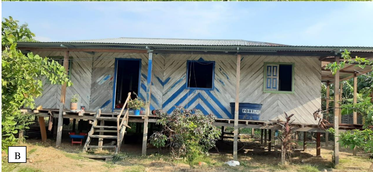
Figura 30: Residência de um morador construtor que reaproveitou parte da madeira de sua antiga casa (A) na construção da nova casa (B) na comunidade de Nossa Senhora das Graças em Manacapuru-AM.
