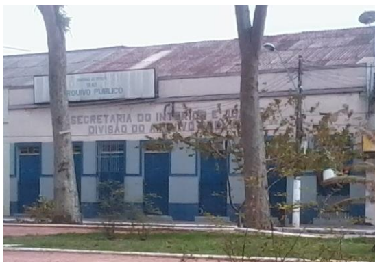
Imagem 58: Fachada do prédio do Arquivo Público.
