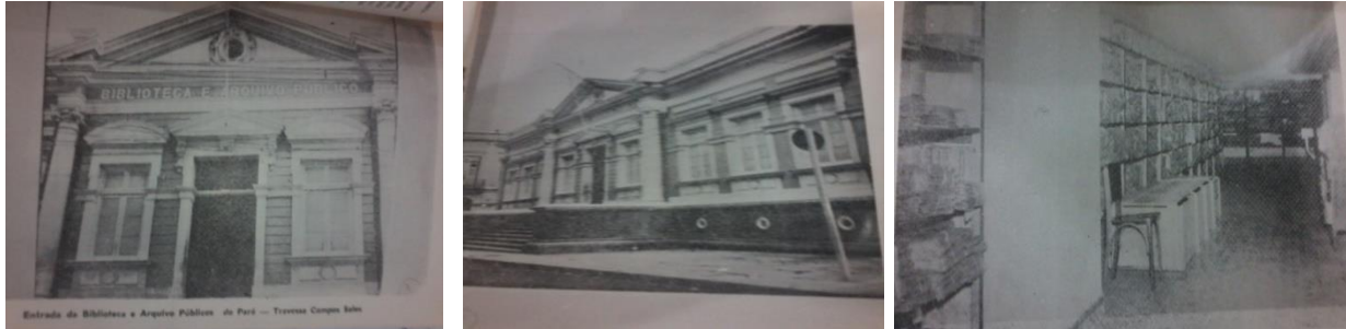
Imagem 1, 2, 3: Entrada do prédio e acervo do Arquivo Público do Pará. Fonte: CRUZ, Ernesto Horacio, 1971.
