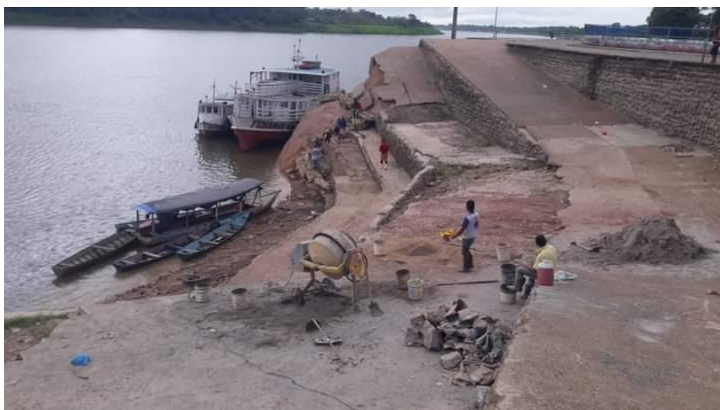
Figura 43: Recuperação e manutenção do muro de arrimo de Barreirinha
