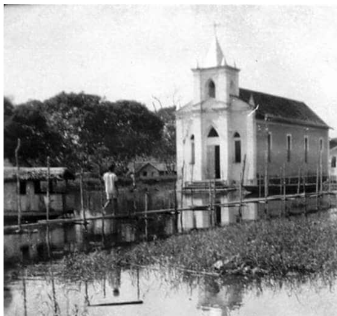
Figura 39: Igreja de N.S do Bom Socorro – Cheia de 1953
