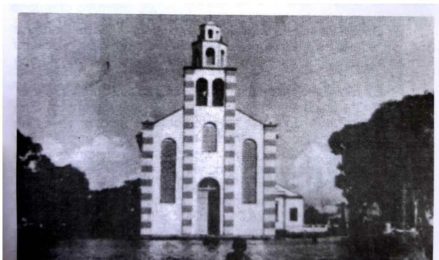
Figura 41: Igreja de N.S do Bom Socorro – Cheia de 1976
