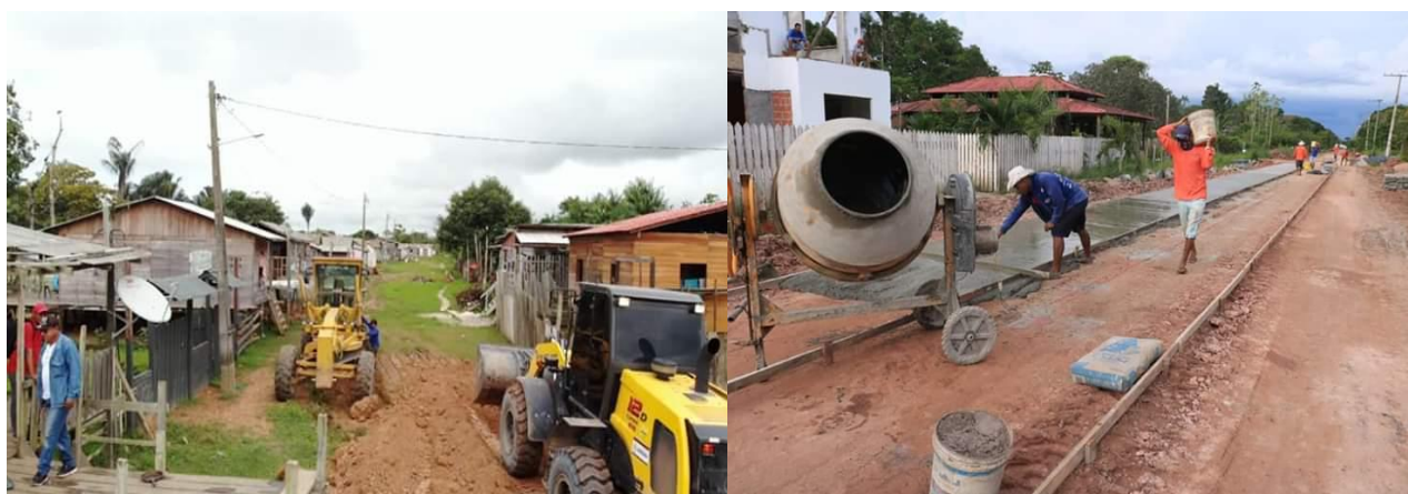
Figura 55: Aterro e Concretagem de Rua na Zona Urbana
