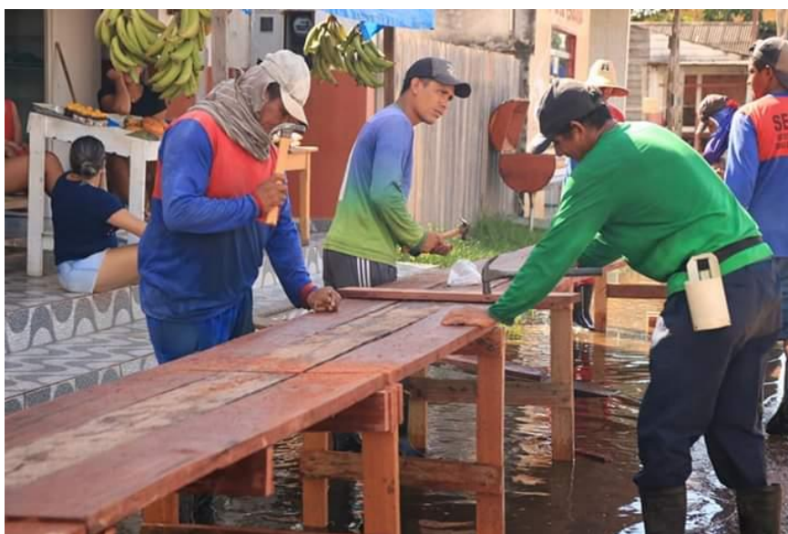
Figura 60: Construção de pontes de madeira – Zona Urbana
