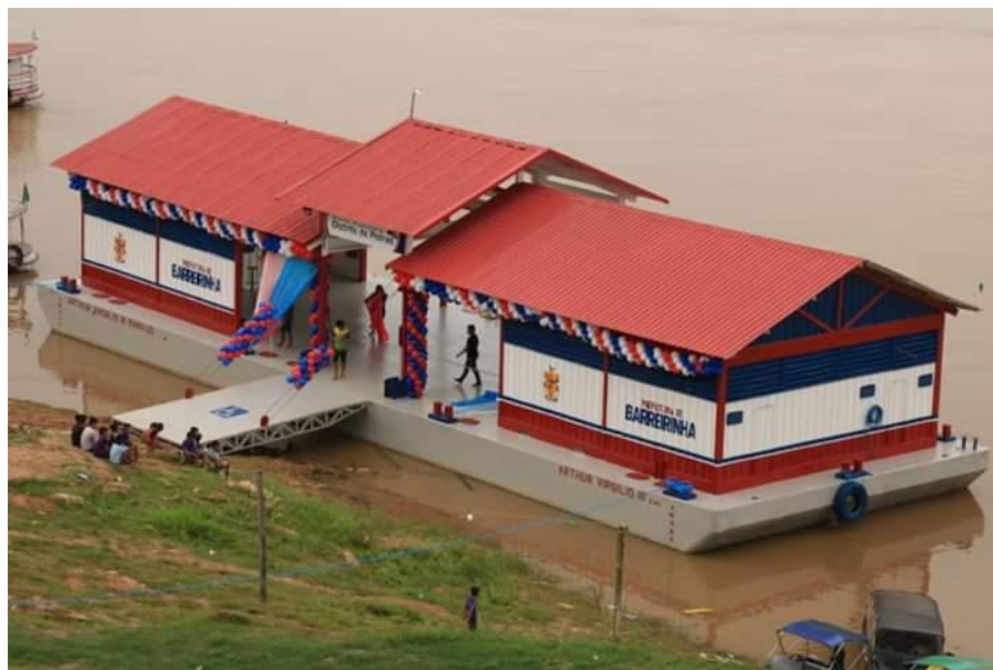
Figura 61: Porto adaptado à cheia e vazante
