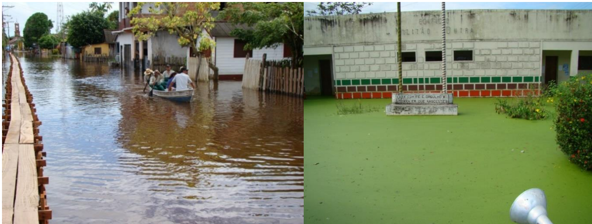
Figura 22: Rua inundada, ponte para trânsito de pedestres e prédio da Prefeitura de Barreirinha inundados (Rua 09 de junho e prédio da Prefeitura inundados pela cheia de 2009)
