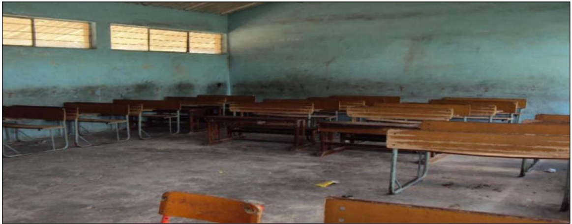
Fotografia 2: Sala de aula da Escola Secundária da Machava-Sede
