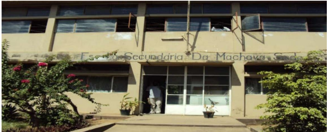
Fotografia 1: Vista frontal da Escola Secundária da Machava-Sede
