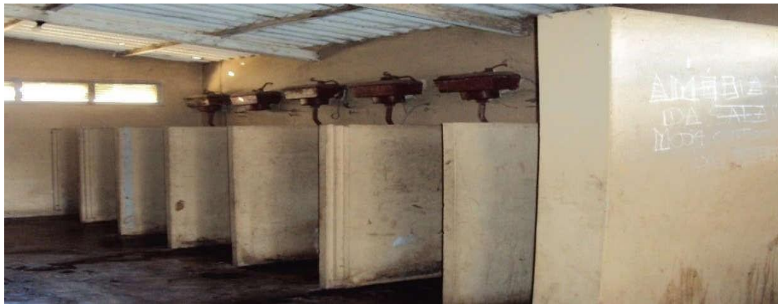
Fotografia 4: Casas de banho da Escola Secundária da Machava-Sede
