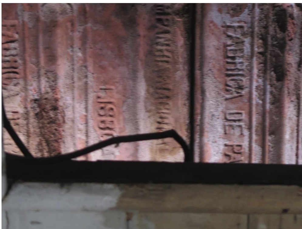
Figura 75 – Telha tipo Marselha fabricadas em Lisboa, Portugal. Fonte. Foto da autora, 2019
