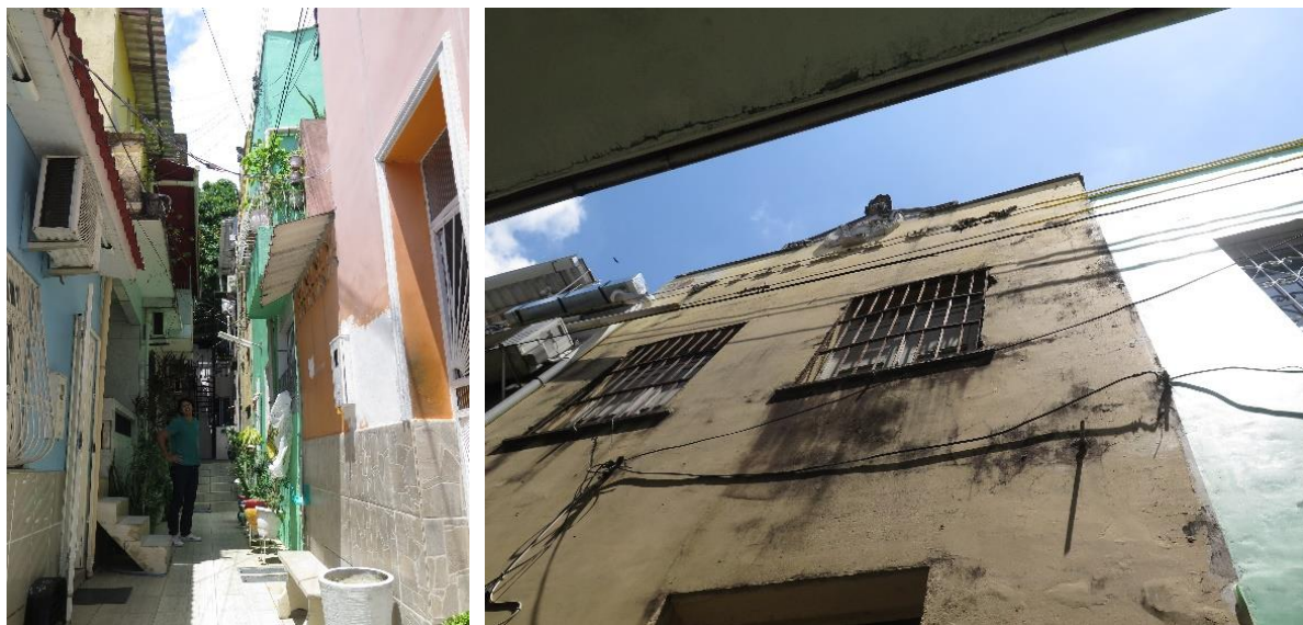
Figura 34 e Figura 35: Villa Lucy – aspecto da via interna da vila. A esquerda interior da via revela as diversas alterações que dificultam a legibilidade da arquitetura. A direita, uma fachada lisa com ornatos ecléticos na platibanda resiste no tempo. Fonte: Foto da autora.2017.
