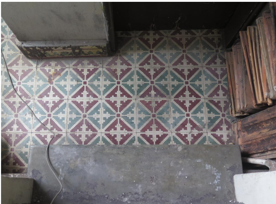
Figura 74: Tipo de Mosaico presente na sala, cozinha e parte do piso superior. Ao lado, várias telhas tipo Marselha, de origem portuguesa empilhadas. Fonte. Foto de Ully Nunes, 2019
