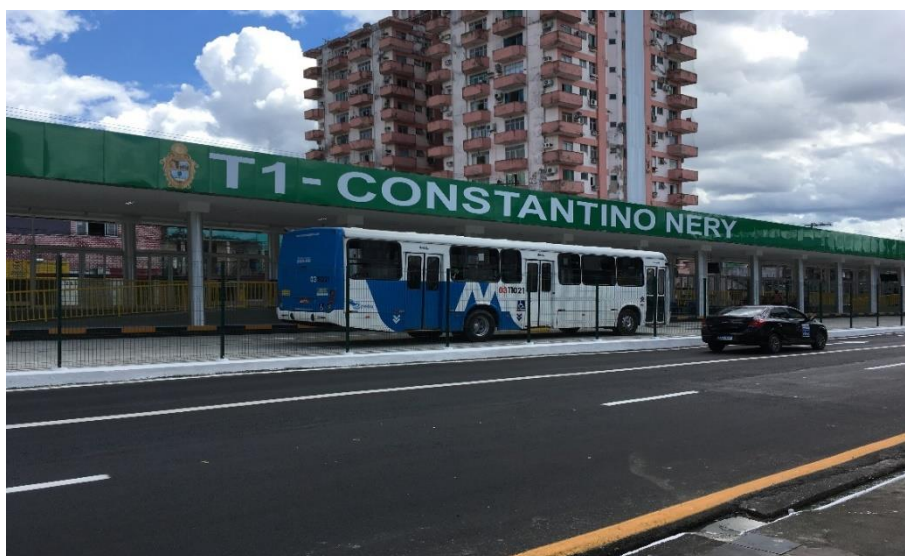
Figura 7 – Vista parcial da Plataforma A, de embarque e desembarque T1.
