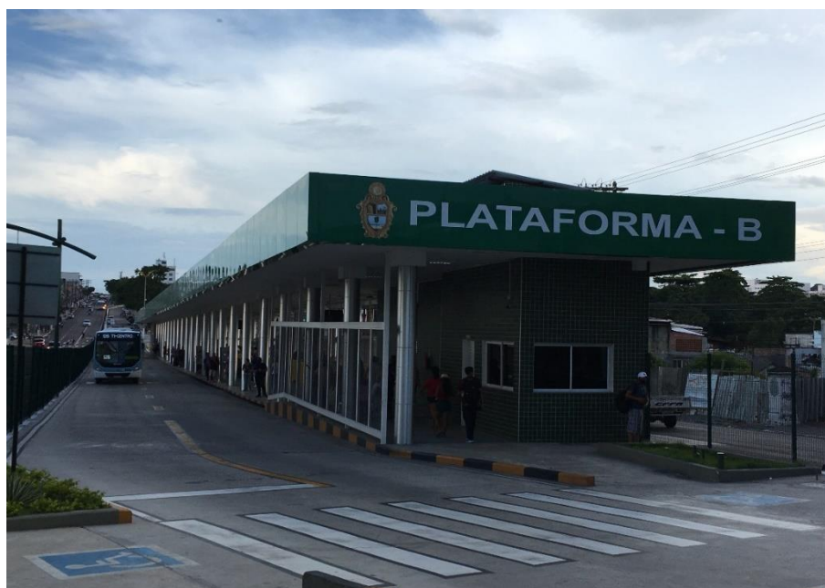
Figura 8 – Vista parcial da Plataforma B, de embarque e desembarque T1.
