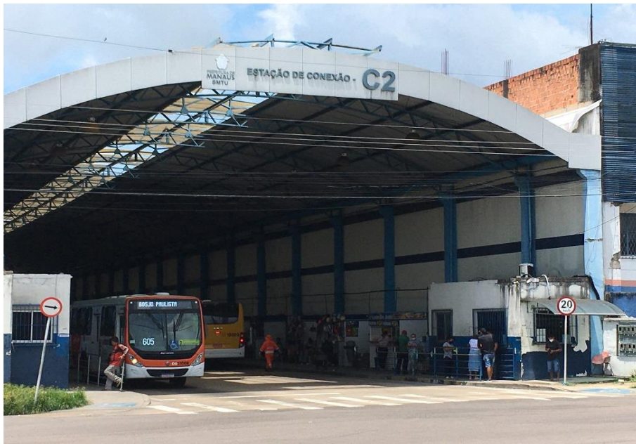
Figura 12 – Fachada da Estação de Conexão – C2.
