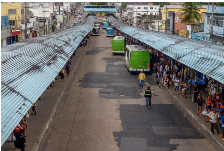
Figura 5 – Vista parcial das Plataformas do T1., na Av. Constantino Nery
