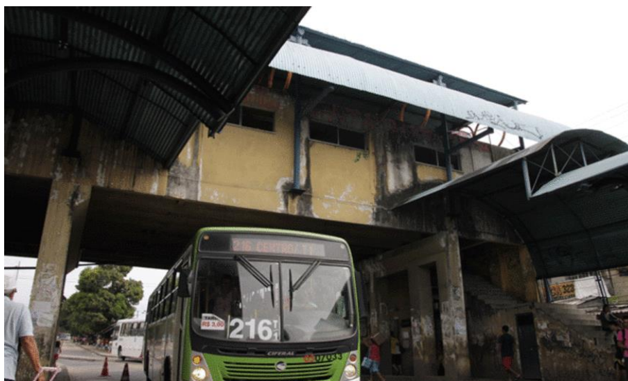
Figura 6 – Passarela do T1
