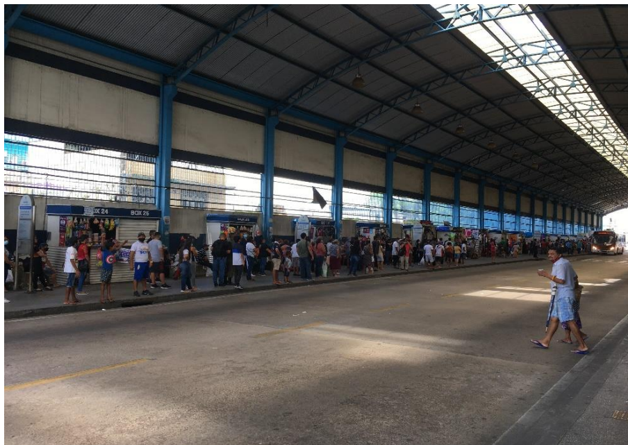
Figura 13 – Vista parcial da Plataforma de embarque /desembarque C2.
