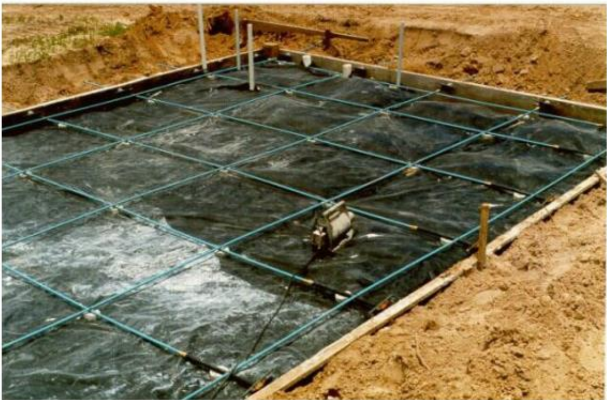
Figura 15 – Radier em concreto protendido (Cauduru 2000)
