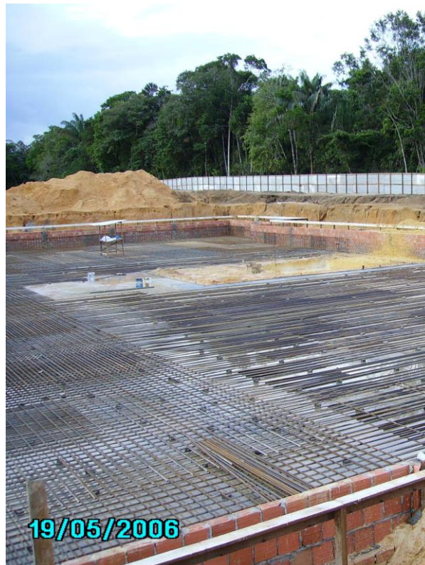
Figura 38: Etapa de construção da fundação do edifício "Minakos" (Próprio autor)
