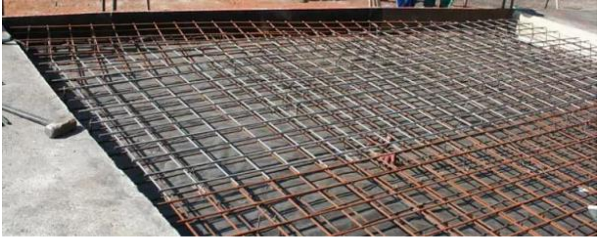
Figura 14 – Radier em concreto armado (Rudini Rodarte Arquitetura & Construções)
