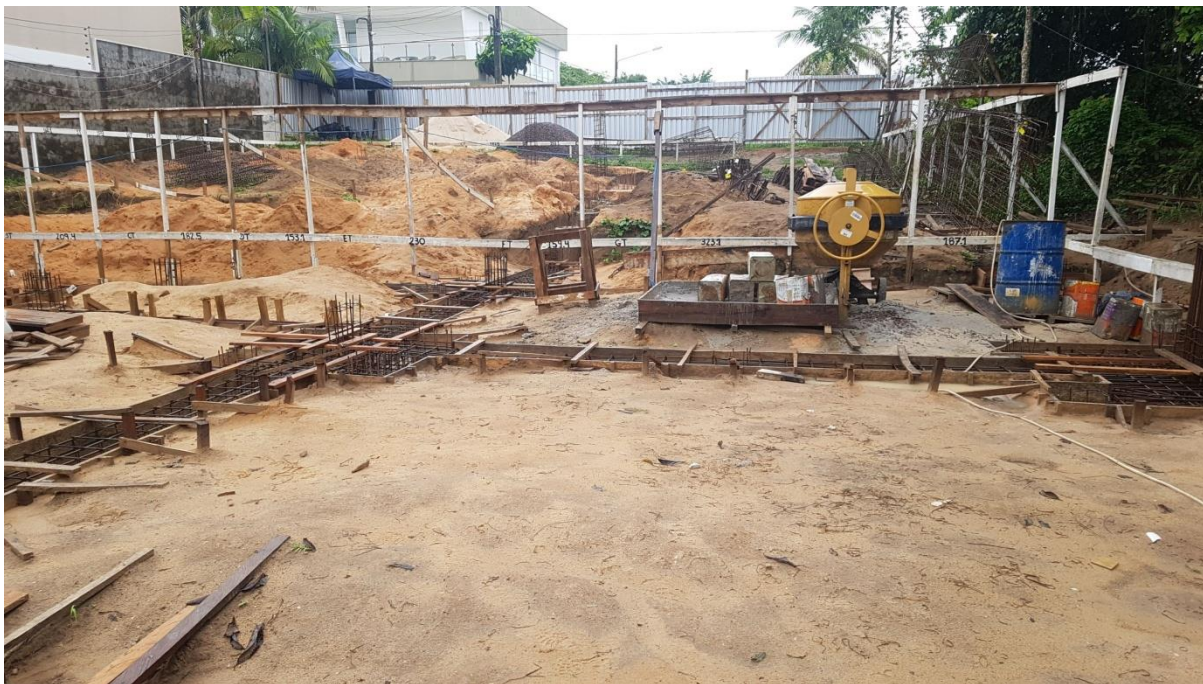
Figura 28: Canteriro de obras atual (Próprio autor)
