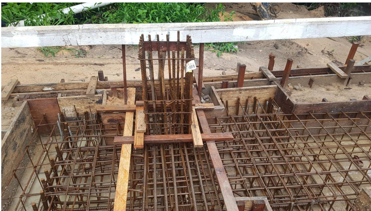
Figura 29: Armação de pilar e viga baldrâme (Próprio autor)
