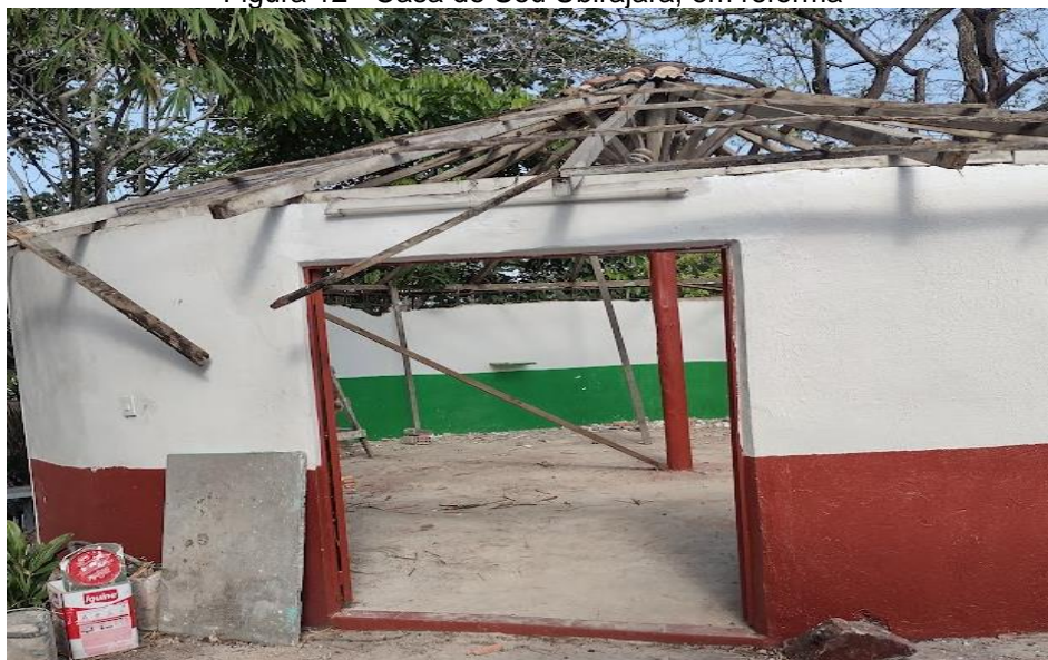
Figura 12 - Casa de Seu Ubirajara, em reforma
