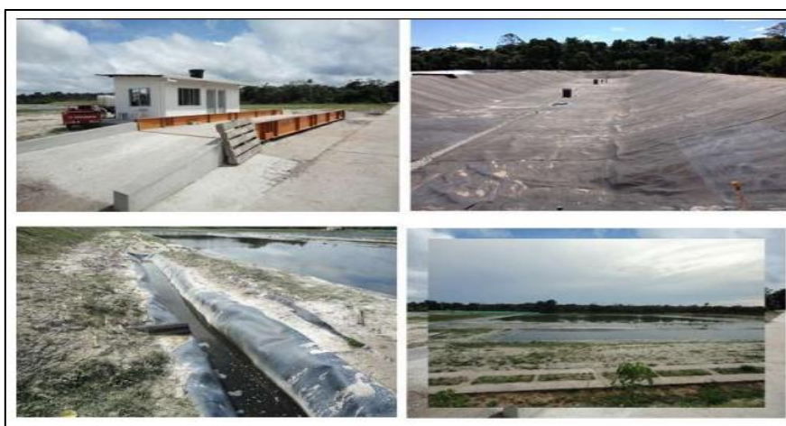
Figura 30 – Fotos aterro sanitário
