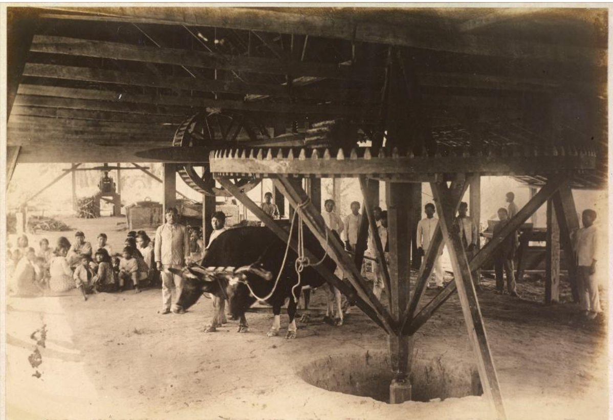
Posto indígena "Marienê", no rio Seruhiny - Aspecto parcial da secção de farinha, vendo-se em destaque accionada por uma junta de bois, a bolandeira construida no posto, a qual fornece energia as machinas. No interior, um grupo de indias Ipurinãs descascando mandioca. (1922)
