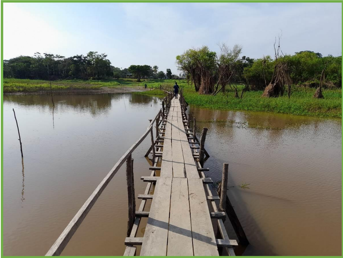
Figura 30. Passarela em madeira para acesso à Comunidade de São Francisco.
