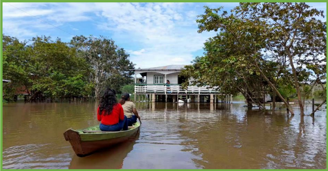
Figura 27. Casa de uma pescadora da comunidade São Francisco em maio de 2022, durante a enchente.
