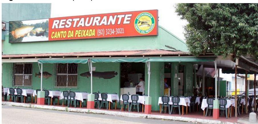
Figura 11 - Fachada principal do Restaurante Canto da Peixada.
