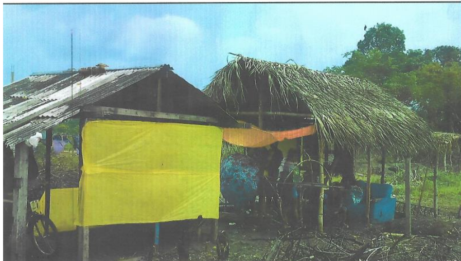
Foto 2 - Barracos cobertos de palha e telhas
