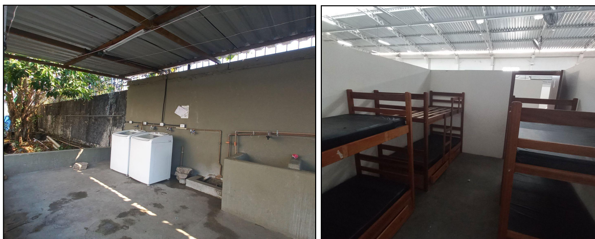
Figura 10: Estrutura do novo Posto de Recepção e Apoio
