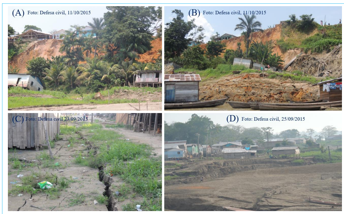
Figura 74: Colapso de terra em Santo Antônio do Içá-AM.
