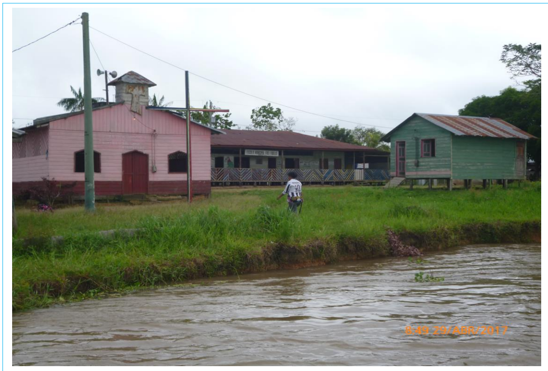
Figura 41: Construções sendo engolida pela erosão fluvial.
