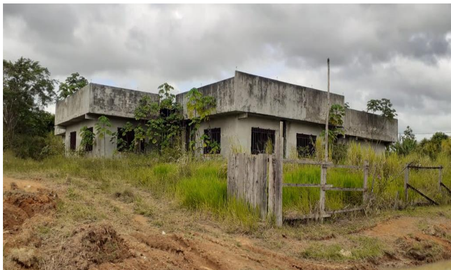
Figura 22 - Estado Atual do Campus Avançado UFRR, Baliza/RR
