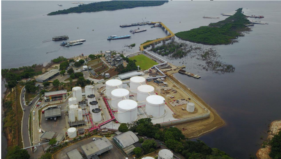
Figura 3 - Distribuidora, ao fundo terminal e tubulações que ligam a refinaria de Manaus.
