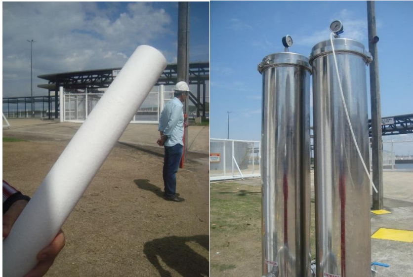
Figura 3 – Elemento filtrante nacional (a) e carcaça (b)
