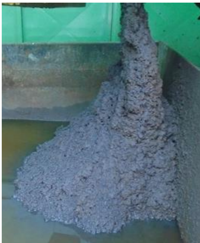
Figura 7 – Tanque de contenção com resíduo de polimento do aro – Ano 2021 – Fonte: (Próprio autor, 2021).
