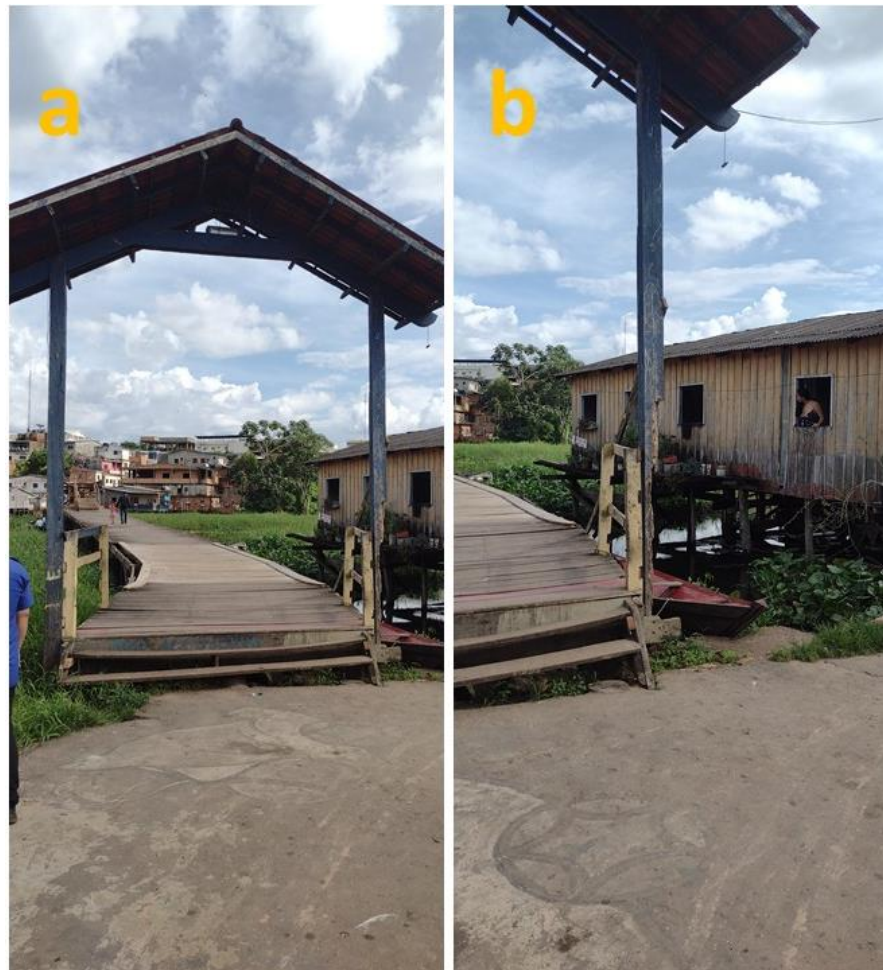
Figura 34: Ponte Raimundo Pinho – Duque de Caxias; P5, a) Entrada da Ponte Raimundo Pinho; b) Trecho da Ponte Raimundo Pinho
