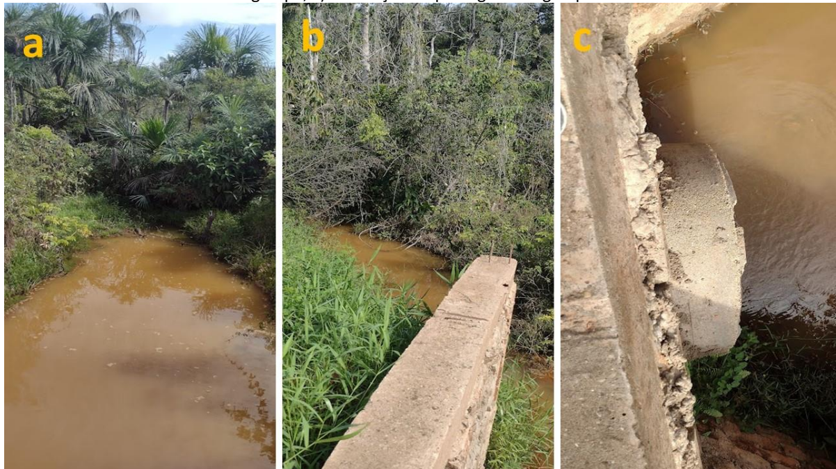
Figura 26: Observações no ponto P1 a) Margem direita do Igarapé Espírito Santo; b) Estrutura de passagem do Igarapé; c) Tubulação de passagem do Igarapé
