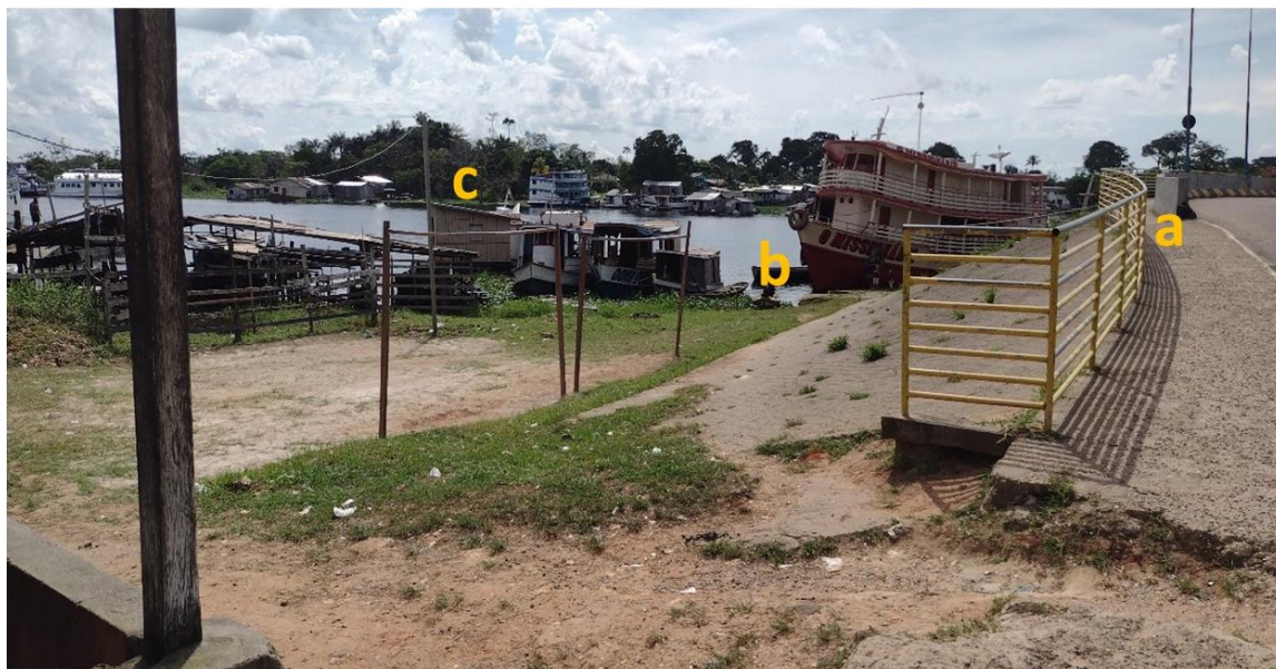
Figura 44: Imagem da Ponte do Pêra: a) lado esquerdo do início da ponte direção centro-bairro; b) Margem do do rio; c) Casas flutuantes.
