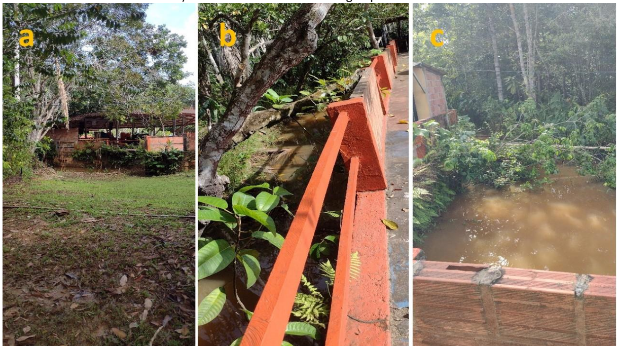
Figura 28: Delimitação da passagem do Igarapé Espírito Santo no P2, EcoPark. a) Estrutura para construção do muro contornando o Igarapé Espírito Santo; b) Lateral construída separando o Igarapé; c) Acesso de concreto sobre o Igarapé dentro do EcoPark.
