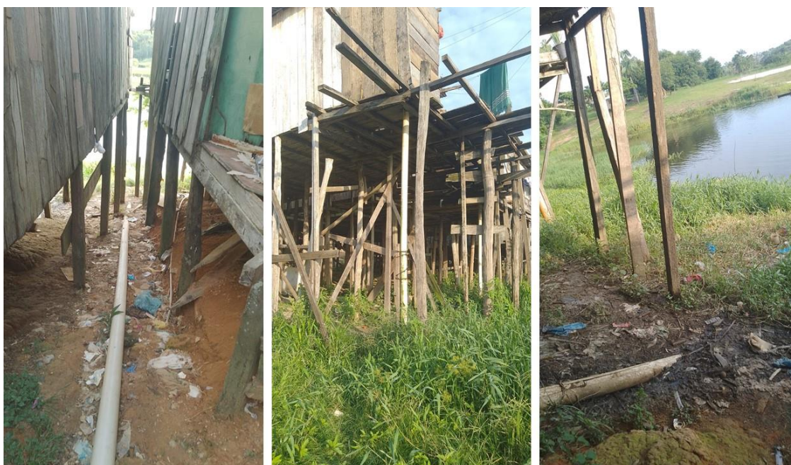
Figura 71: Canalização direta no Igarapé Pêra
