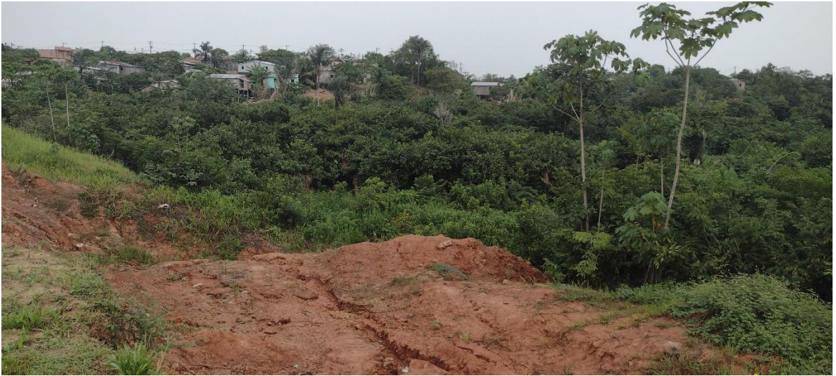
Figura 89: Registro das margens e existência de substrato no ponto P2 do Igarapé Pêra.
