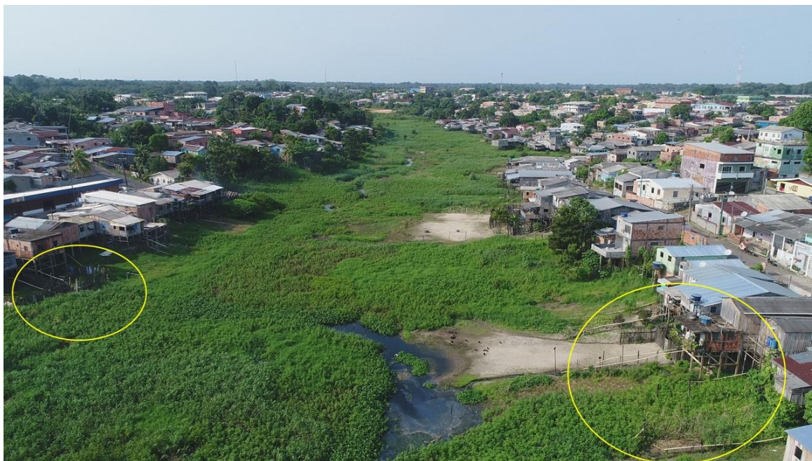
Figura 70: Canalização direcionada para despejo no Igarapé Espírito Santo
