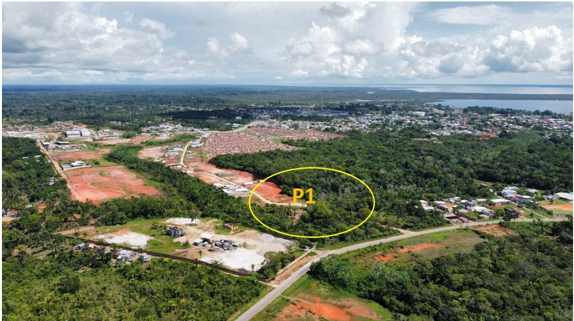
Figura 54: P1 Passagem de acesso da Estrada Coari Itapeua ao Conjunto Residencial Iacy Dantas.
