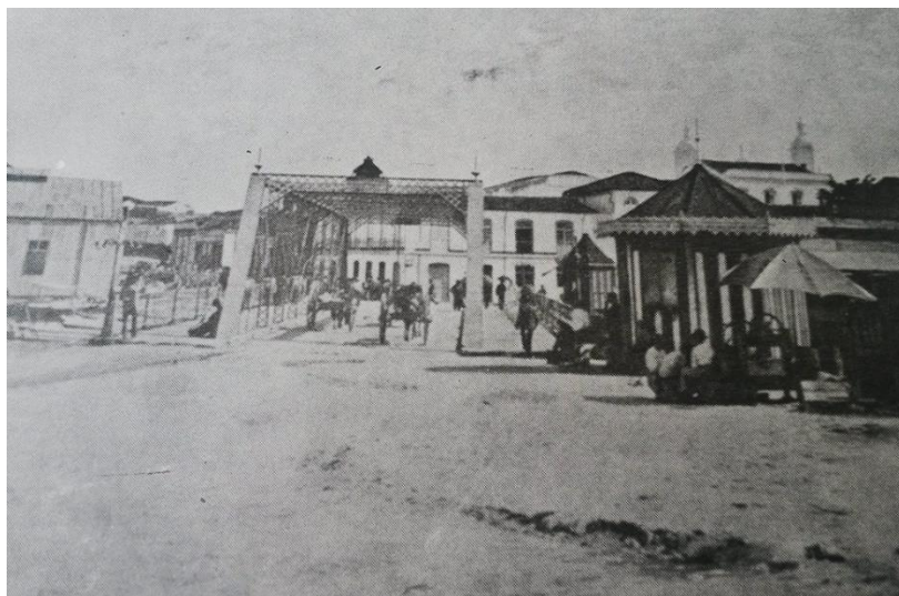
Figura 5 – Ponte dos Remédios (1882)
