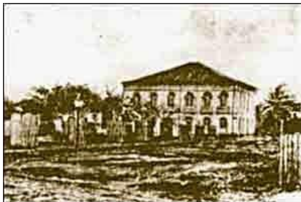
Figura 8 – Liceu em 1870 durante a sua construção
