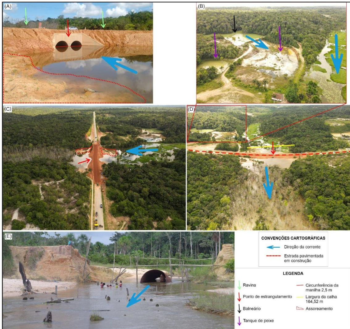
Figura 36 – Avenida Cláudio Mesquita no cruzamento da ponte sobre o igarapé do Mariano com a intervenção da ponte e os impactos ambientais negativos.
