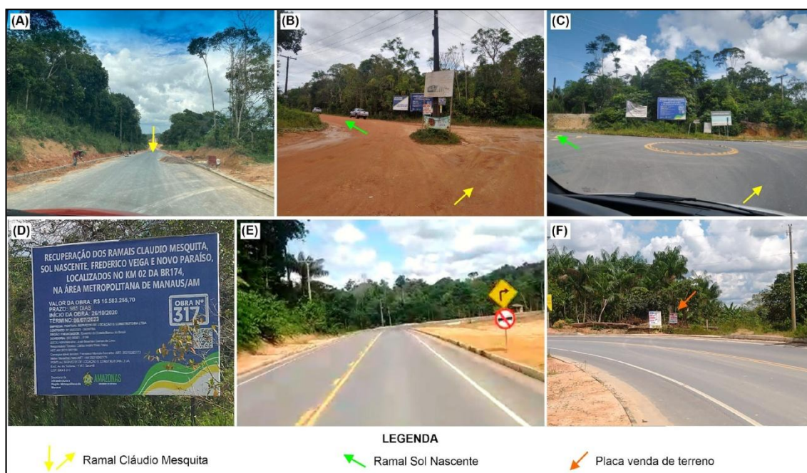
Figura 28 – Avenida Cláudio Mesquita, Ramal Sol Nascente e Ramal Novo Paraíso recebendo obras de pavimentação.
