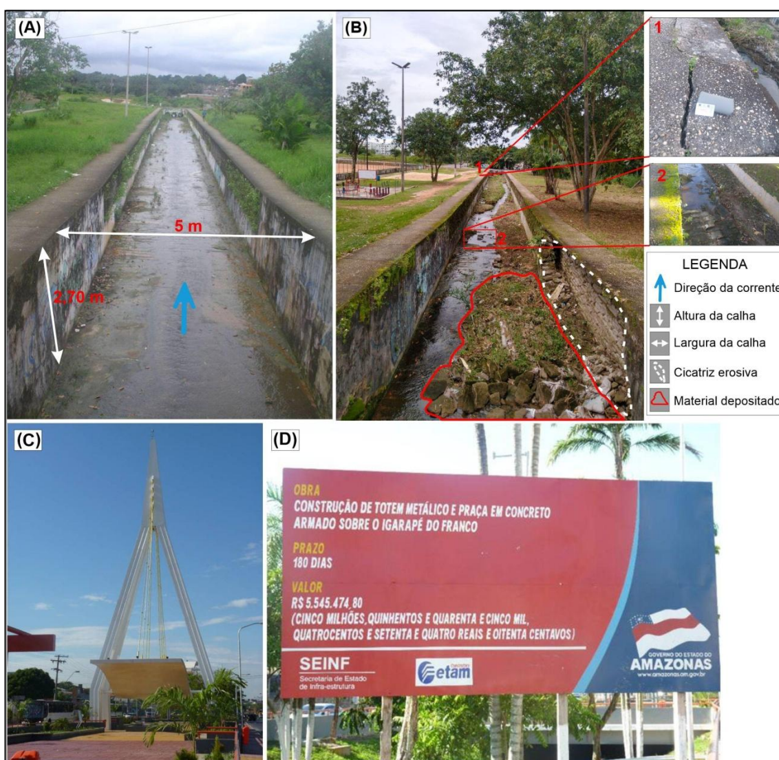
Figura 17 – (A) e (B) Retificação da calha do curso d'água por obra de engenharia no afluente do igarapé dos Franceses no Conjunto Santos Dumont (Zona Centro-Oeste) em anos diferentes. (C) Obra do Estado sobre a calha do igarapé do Franco (Zona Oeste) e (D) valor da construção da obra.
