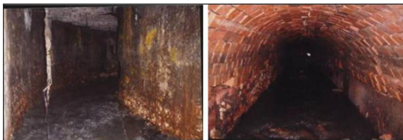
Figura 6 - Galerias subterrâneas construídas pelos ingleses canalizando os igarapés.
