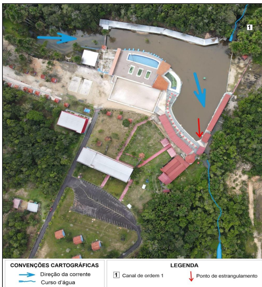
Figura 32 – Balneário do Sindicato dos Metalúrgicos do Amazonas (Sindmetal-AM) localizado na margem direita do igarapé do Mariano com as alterações na área de encosta, na planície de inundação e no curso d'água.
