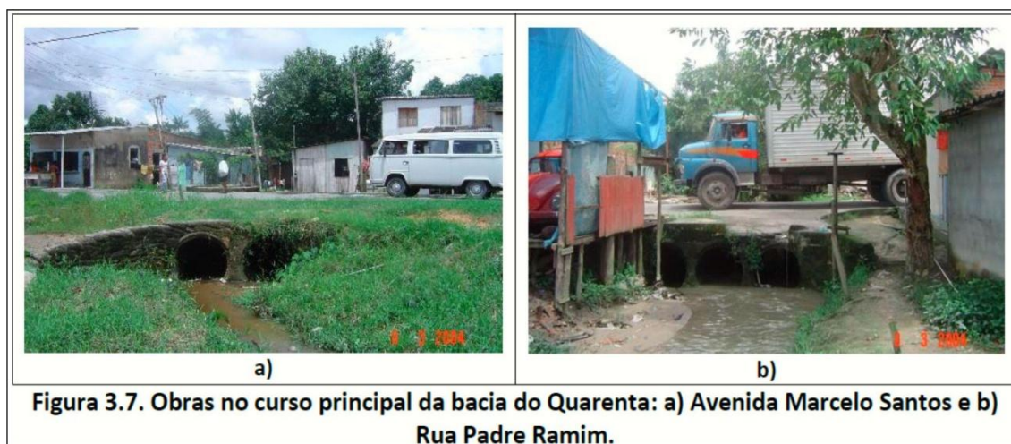
Figura 37 – Intervenções com manilha (tubos de concretos em torno de 2 metros de diâmetro) sobre o Igarapé do Quarenta no Bairro Zumbi dos Palmares na Zona Leste de Manaus.
