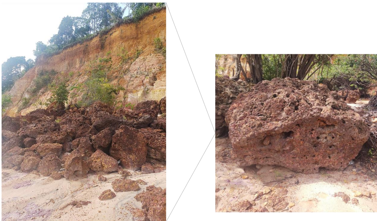
Figura 8 — Presença de crostas lateríticas na Falésia 4
