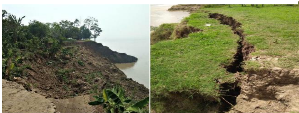
Foto: Defesa Civil (2018) apud SERRUYA (2022)
