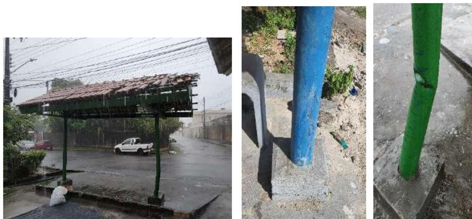
Figura 53 Abrigos com estrutura danificada e pintura desgastada
