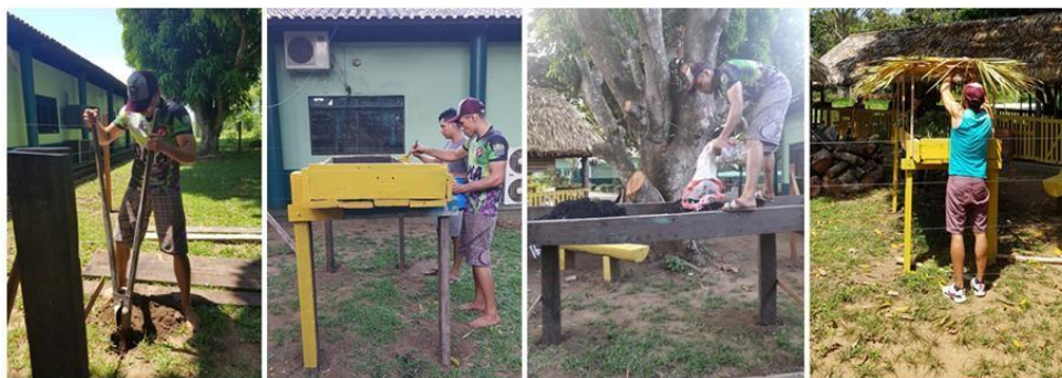
Figura 1 - Construção dos balcões e acondicionamento do adubo orgânico
