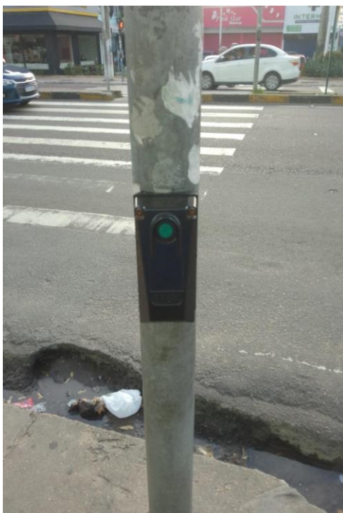
Figura 83: Faixa de pedestre na avenida Djalma Batista
