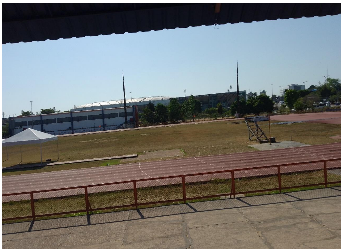
Figura 110: Vista da arquibancada
