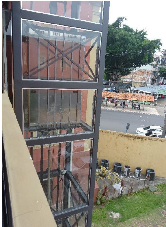
Figura 67: Elevador Visto por Fora
