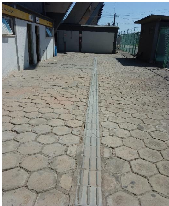
Figura 27: Caminho do piso tátil
