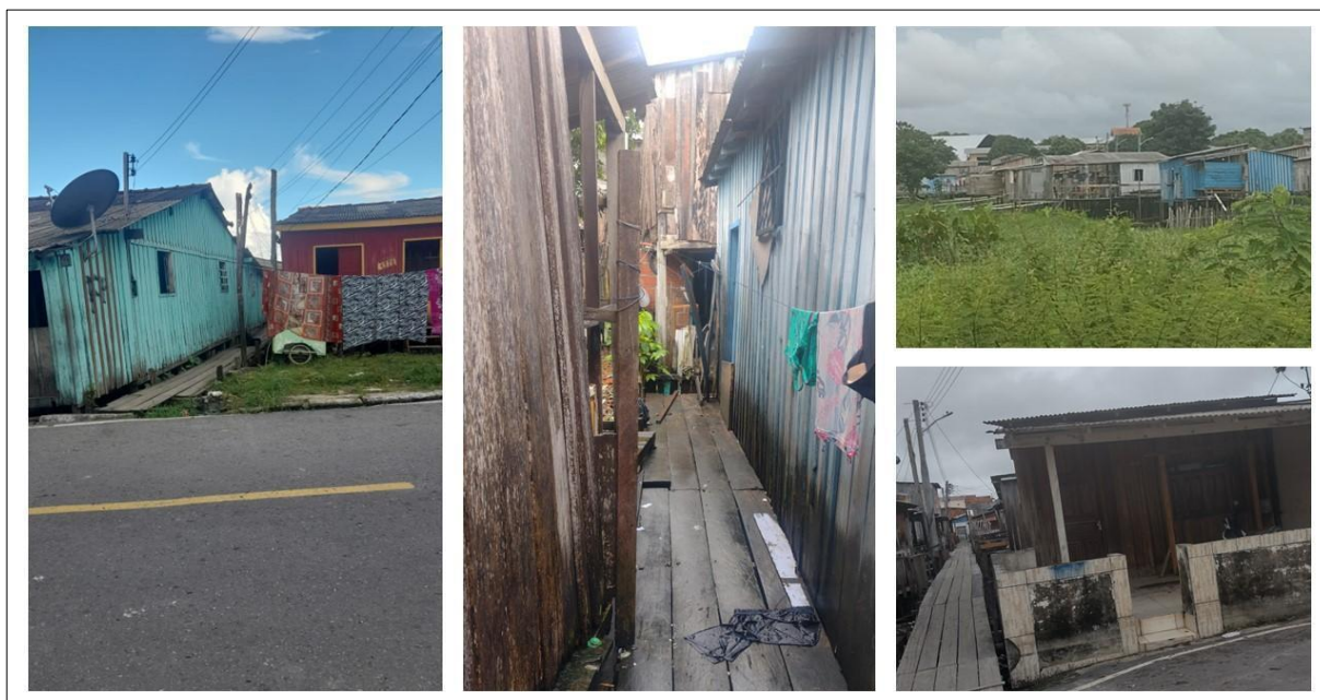
Figura 25 - Padrões construtivos e acesso entre as palafitas em Parintins-AM
