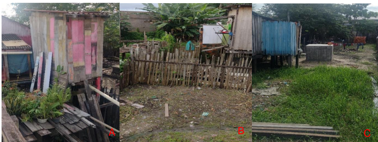
Figura 47 - Construção de sanitário e banheiro
