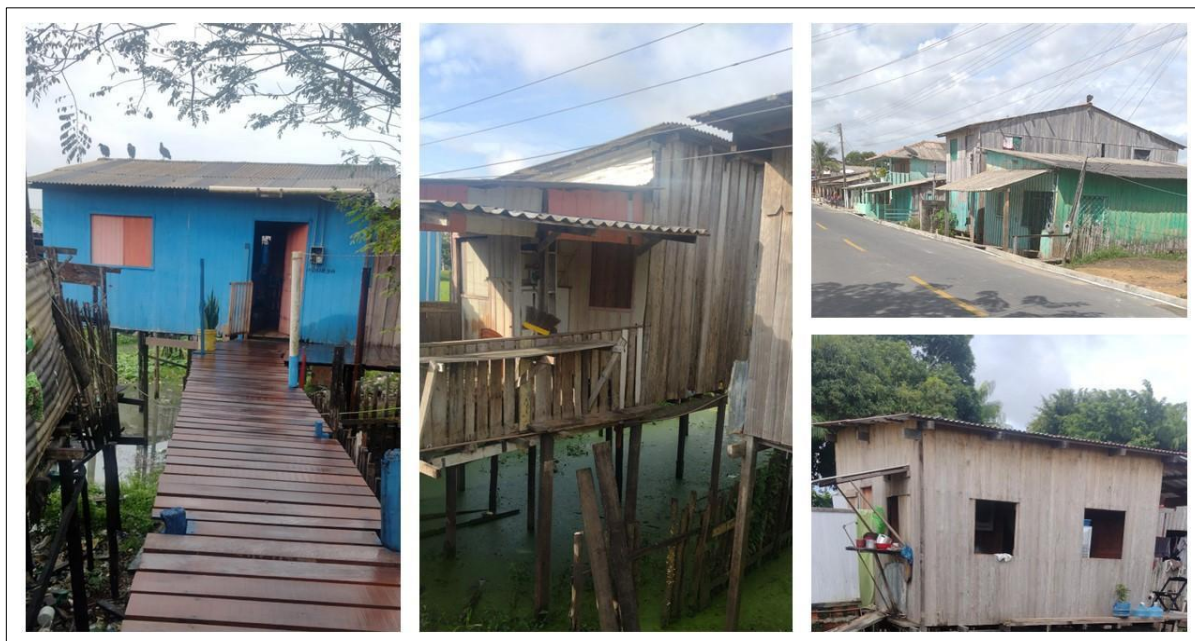
Figura 26 - Moradia de palafita e suas formas de construção
