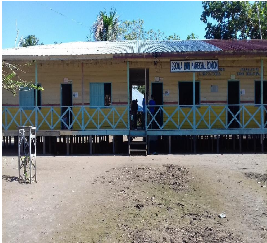
Imagem 2 – Estrutura da Escola Municipal Marechal Rondon de ano de 2018
